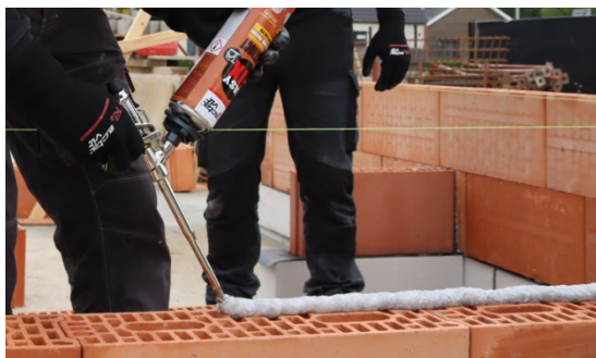
Figuur 1: aanbrengen van de lijm
